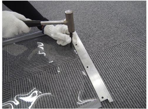
3. 金具固定ネジセットを使用し、本体取付金具に図1を参考にシートを固定します。
